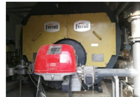
白洋淀学院更换燃气蒸汽锅炉
