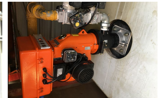
广州米兰花更换燃气锅炉燃烧机
